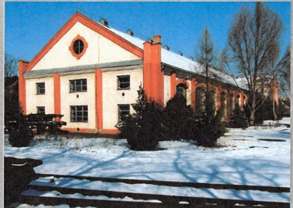
21./B Körösi út – MÁV járműjavító egykori főnökségi épület
