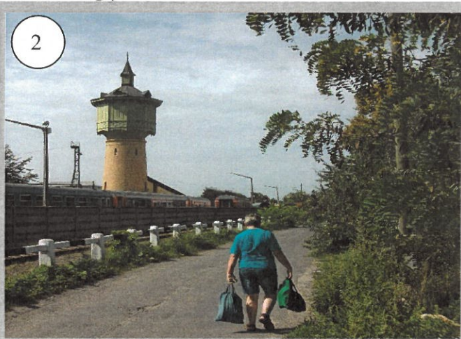
20. Víztorony, MÁV-Járműjavító MJSZ.:10339
